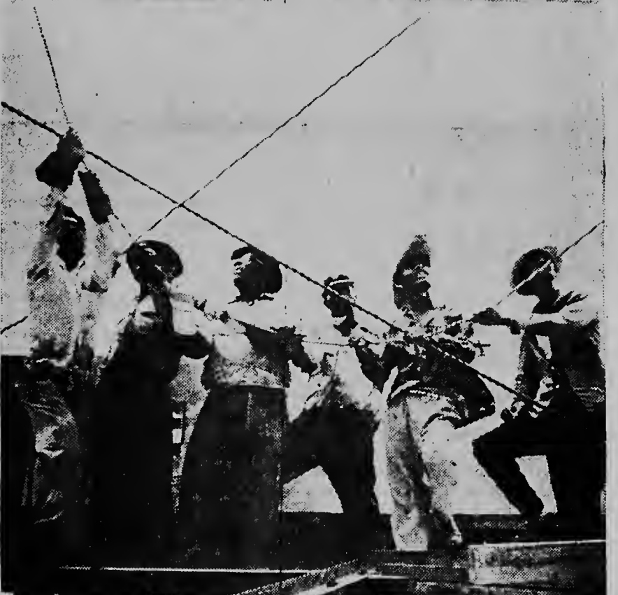
Bao di controle di senior C. Kollard, contrastista di Bouw Maatschappij Aruba N.V., nan a hisa ayera e prome spant pa dak di e teatro. E biga di herro aki cu ta midl 16 meter largu, y esun di mas chiki den e enateran cu mester worde pone ta pisa mas o menos un ton y mei y no tabata tin cos chiki pa hanja e spant aki na su lugar. E spant numero cuater cu ta 24 meter largu lo pisa casi dos ton y mei. E portretnan ta duna un idea cu e trabao ta marcha.
